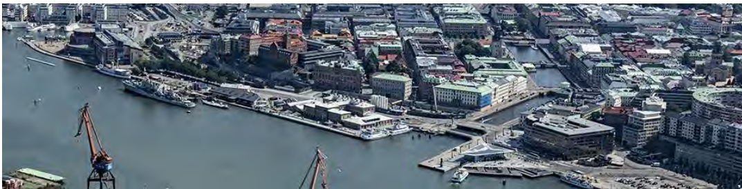
Figur 26. Flygfoto där Stora Hamnkanalen som huvudentré från vattnet är tydlig. Källa: Göteborg stad. Figuren visar ett urklipp.
