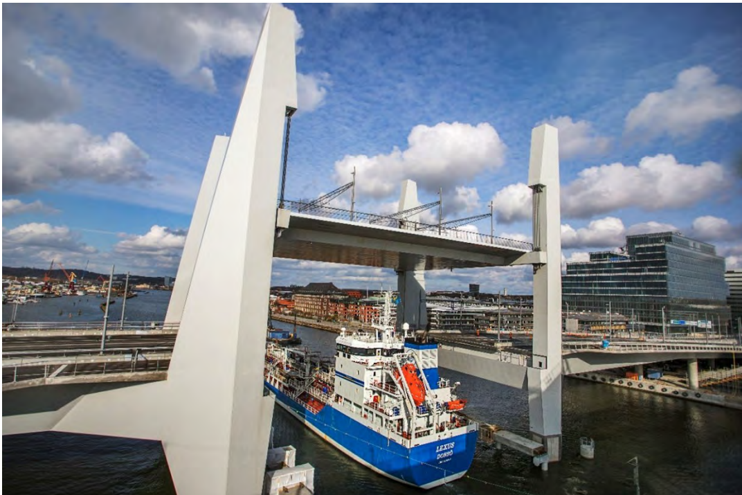
Figur 19. Broöppning vid Hisingsbron för passage av lastfartyg. Källa: Sweco.
